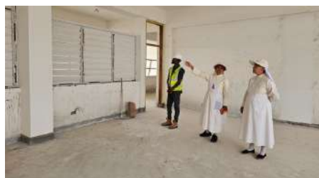
Discussion sur l'avancement du chantier
