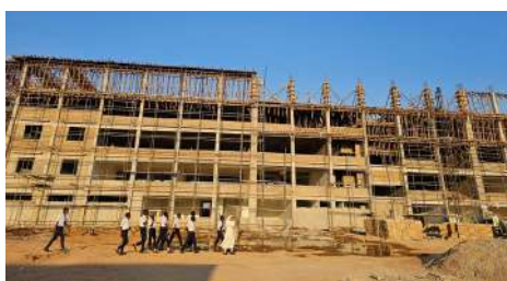
Construction du bâtiment : juin 2024
