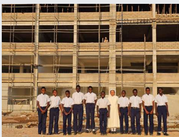
Juin : Début de la phase 2 du projet : construction d'un bâtiment sur 5 étages comprenant 36 dortoirs-réfectoires.
