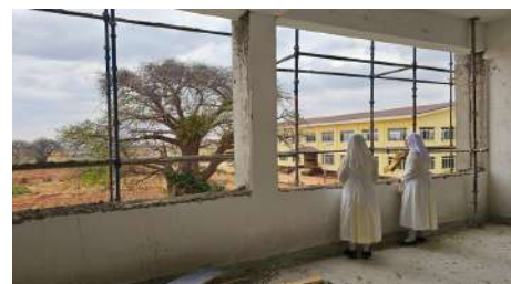
Construction du bâtiment : octobre 2024
